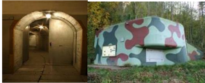
Eingang der Anlage Schiessscharte Richtung Nord-Osten
